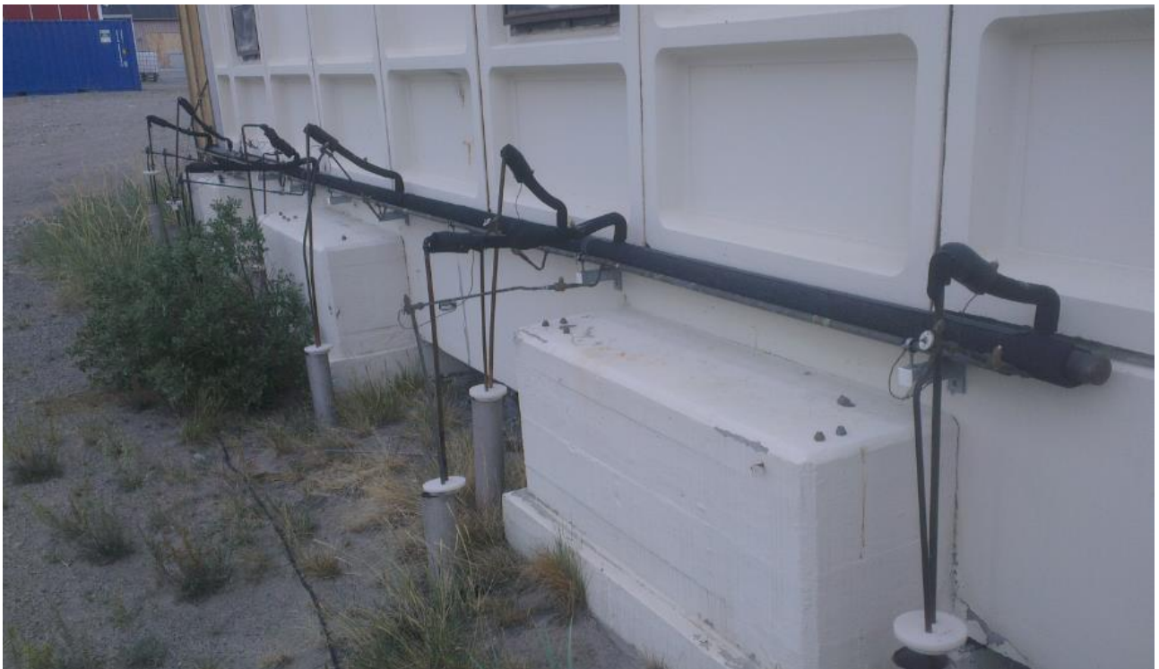
Figur 6-13 Køle slanger til afkøling af jordlagene
