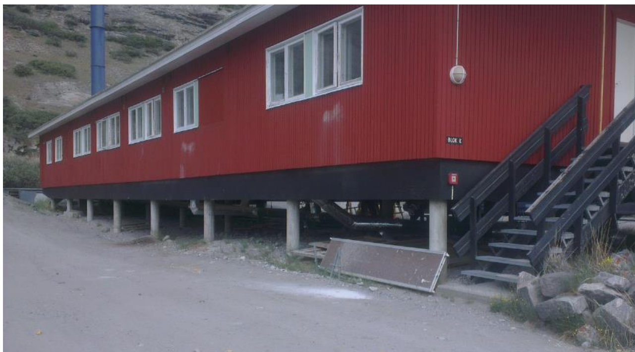
Figur 6-9 Typisk pælefundering.
