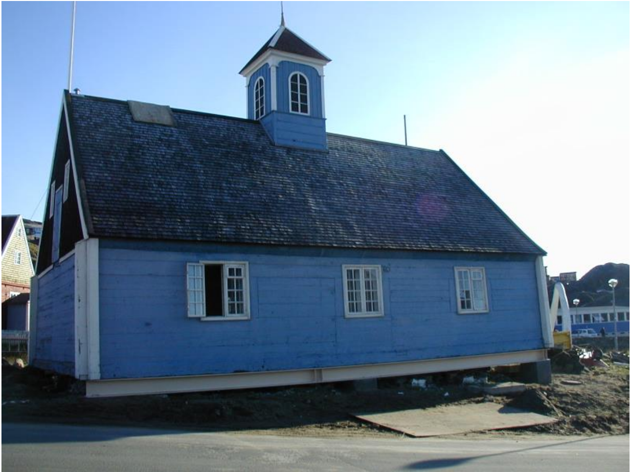
Figur 6-1 Den gamle kirke i Sisimiut sat oven på et I profil, for at sikre den mod sætninger. Foto: Egil Borchersen
