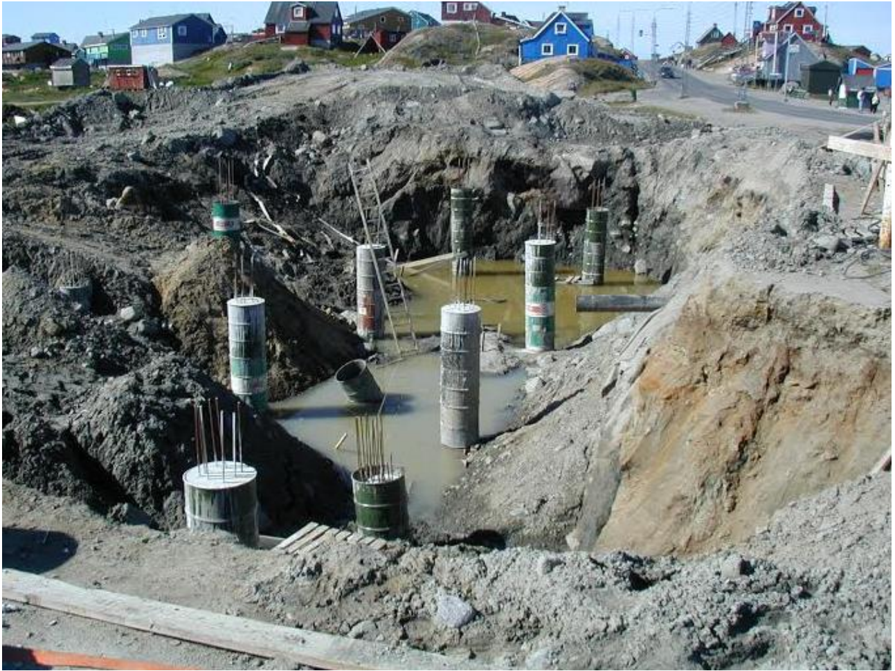
Figur 6-8 I sammensvejsede tønder støbes pælene til fundamentet til Tele-Post bygningen i Sisimiut Foto: Egil Borchersen
