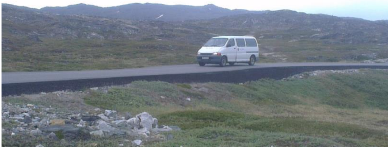
Figur 6-17 tyk asfalt lag på lufthavsvejen over et stræk med permafrost.
