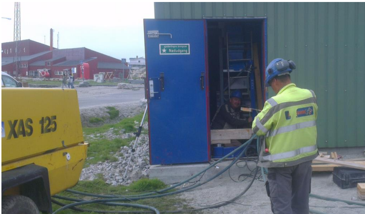
Figur 6-16 Hallens konstruktion rettes op ved brug af donkrafte.
