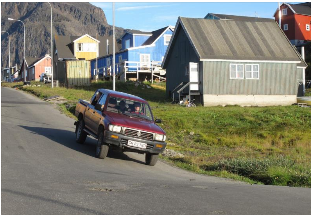
Figur 6-7 Hullet i vejen er en sætning, der er opstået grundet permafrost, der er tøet. Foto: Lånt fra slideshow af Thomas Ingemann Nielsen
