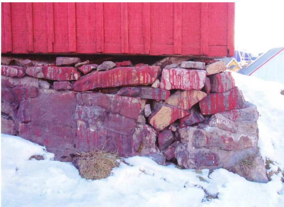
Figur 6-2 Det oprindelige fundament ses tydeligt, med cement imellem stenene, løse sten er lagt oven på for at støtte huset. Foto: Niels Foged
