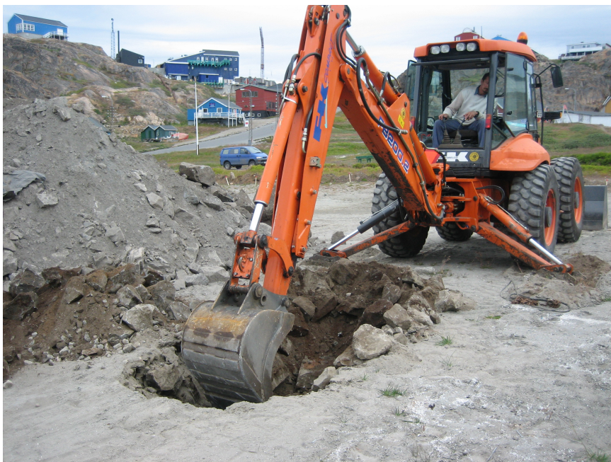
FIGUR 4: RENDEGRAVER SOM VAR VENLIGT UDLÅNT AF BYGGE & ANLÆGSSKOLEN. DENNE BLEV BENYTTET TIL, AT GRAVE 4 HULLER DEN 13. AUGUST 2008. DETTE ER DEN FØRSTE GRAVNING SOM LIGE ER PÅBEGYNDT. DET FREMGÅR AF BILLEDET AF DER I DET ØVERSTE LAG FOREFINDES MANGE STORE STEN.
